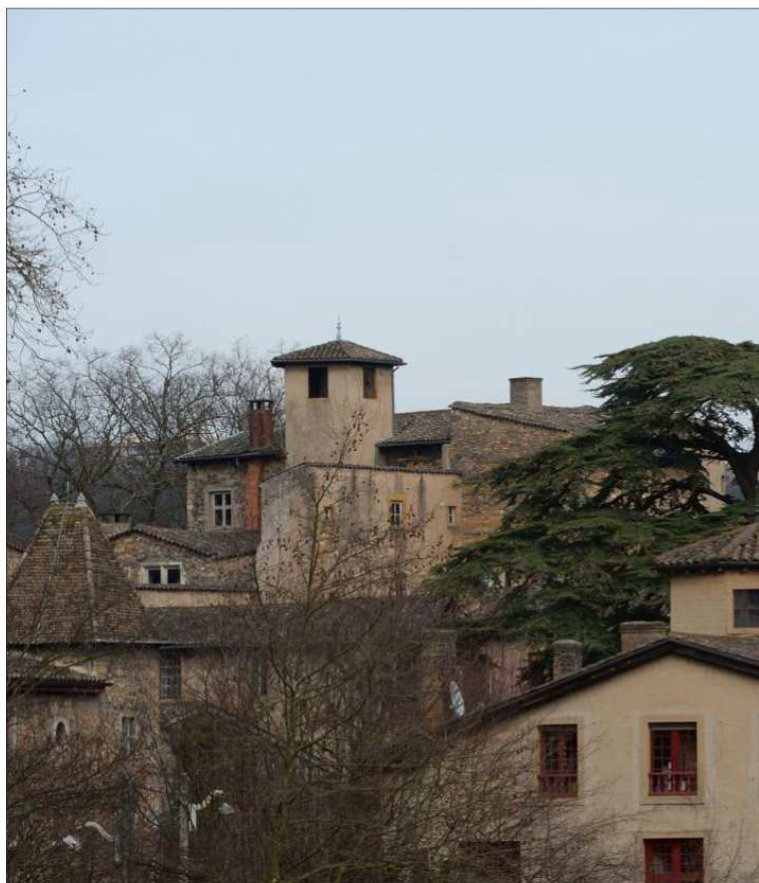
■ Vue depuis le pont de l'Île Barbe : le clocher de la chapelle et ses échafaudages.
