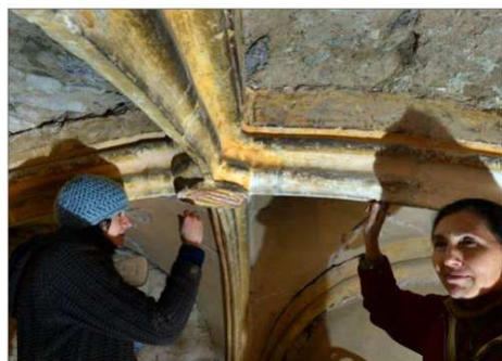
Sur la claf de voûte, les spécialistes dégagent la peinture au scalpel pour retrouver le bleu initial. Photo Philippe JUSTE
